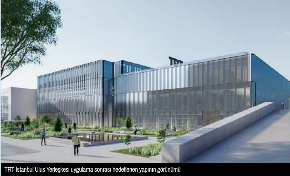
TRT İstanbul Ulus Yerleşkesi, Yeşil Bina görünümü
