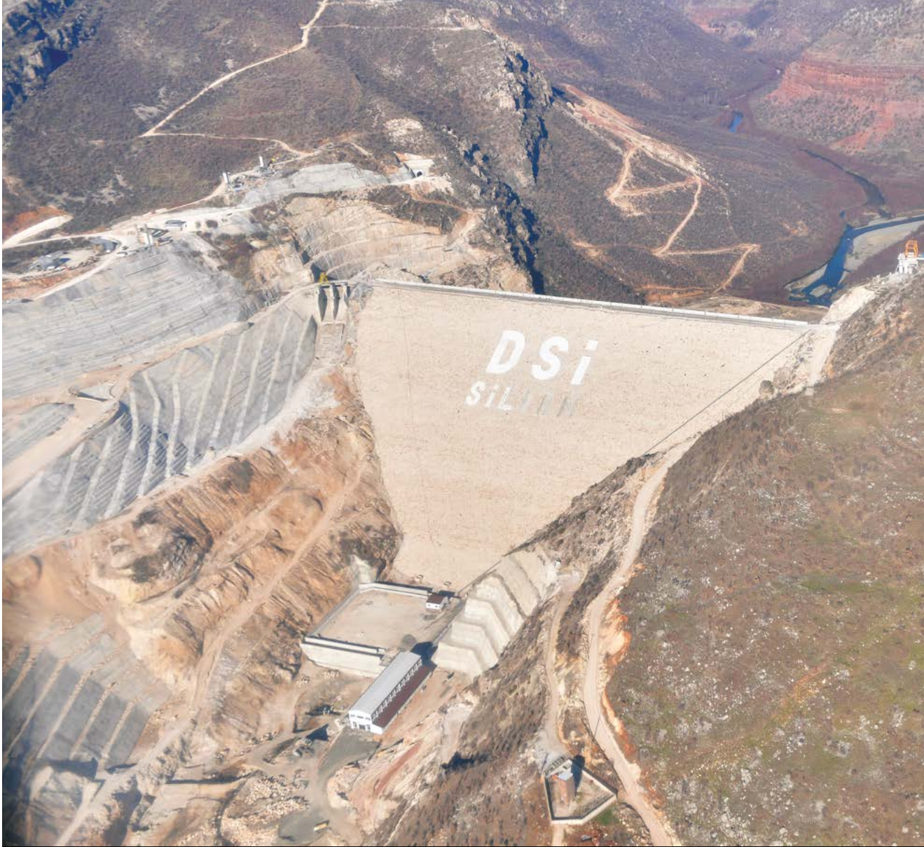
GAP'ın en önemli parçalarından olan Diyarbakır Silvan Barajı tamamlandığında, Atatürk Barajı'ndan sonraki en büyük sulama barajı olacak
