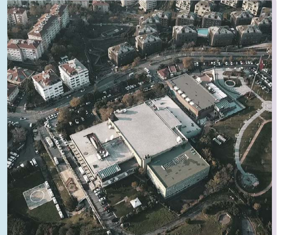
Hava fotoğrafı ile TRT İstanbul Ulus Yerleşkesi görünümü
